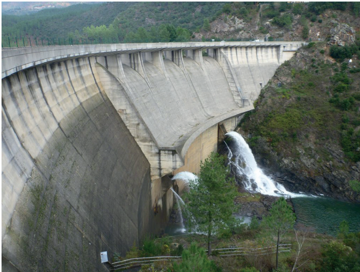
Barrage de Sénéchas © Photo BRL - E. Vuillemeret
